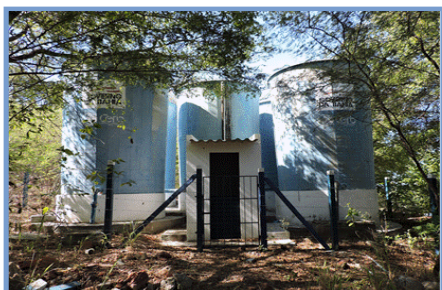
Figura 3-10 – Reservatórios - Comunidade Alto da Serra
