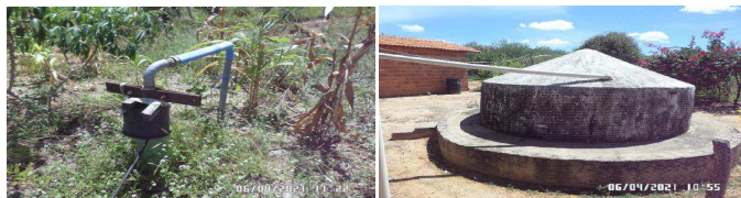
Figura 61 – Poço Artesiano e Cisterna- Comunidade Muquém
