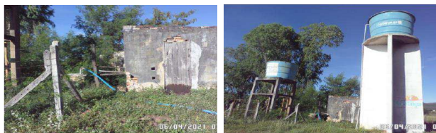
Figura 59 – Poço Artesiano e Reservatório- Comunidade Alagoas
