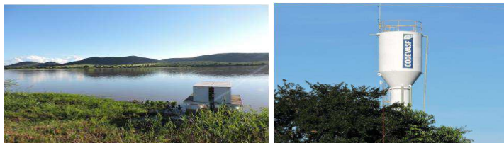
Figura 37 – Captação e Reservatório da Comunidade Canafistula I
