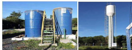
Figura 38 – ETA e Reservatório Elevado da ETA
