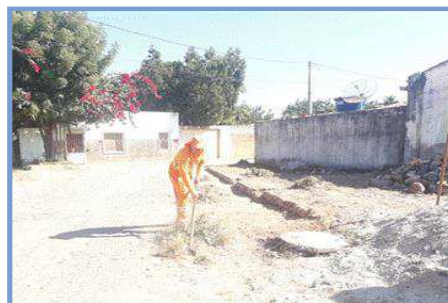
Figura 3-29 – Agentes de caiação e capinação Fonte: COBRAPE (2021)
