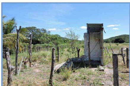
Figura 3-4 – Poço artesiano – Passagem de areia Fonte: COBRAPE (2021)
