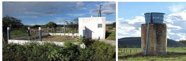
Figura 42 – Poço Artesiano e Reservatório- Comunidade Sanharol
