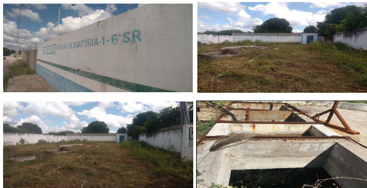
Figura 33 - Estação Elevatória de Esgoto
