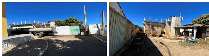
Figura 27 – ETA 1 – Estação de Tratamento da Água – ETA SEDE
