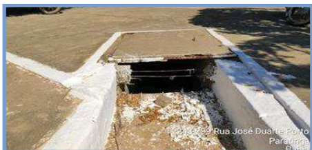
Figura 3-40 – Exemplo de boca de lobo
