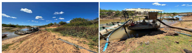
Figura 23 - Captação Superficial
