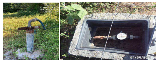
Figura 70 – Poço Artesiano e Ligação com Hidrômetro- Comunidade Lagoa Danta
