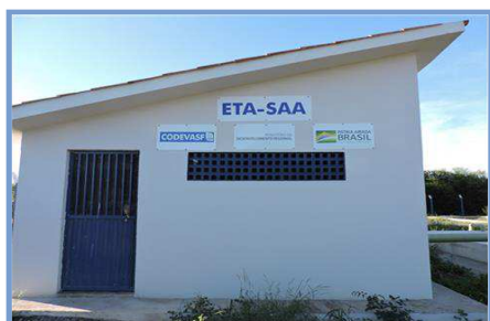
Figura 3-12 – Estrutura da ETA construída pela CODEVASF
