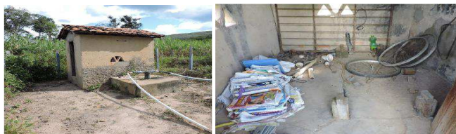
Figura 53 – Poço Artesiano e Casa de Estoque- Comunidade de Pedras
