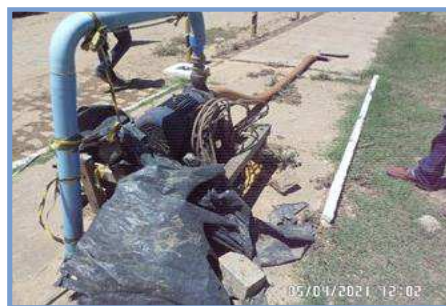
Figura 3-42 – Conjunto motobomba alocado na praça Elmir de Souza
