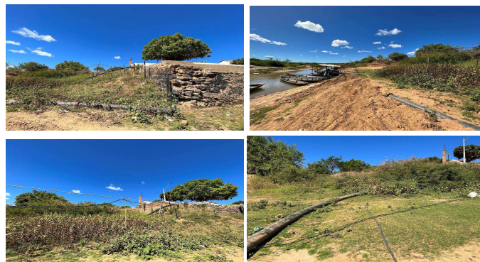
Figura 24 – Adutora de Água Bruta
