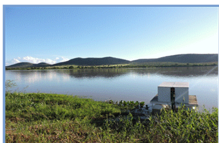
Figura 3-13 – Ponto de captação no rio São Francisco – Comunidade Extrema
