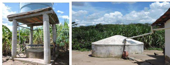
Figura 72 – Poço Artesiano e Cisterna - Comunidade Carrapicho
