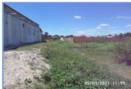
Figura 3-50 – Trecho natural do canal da Avenida Rio Branco
