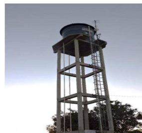
Figura 58 –Reservatório- Comunidade de Pereira
