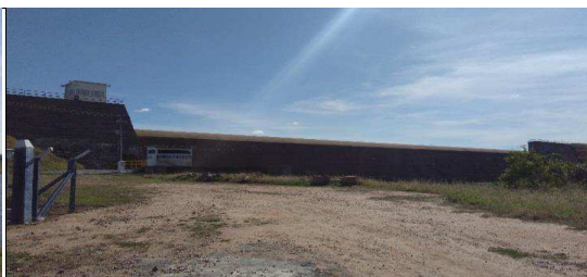
Foto 2 – Vista Barragem de Pedras Altas
