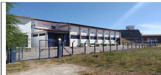
Foto 9 – EEAB I Barragem de Pedras Altas
