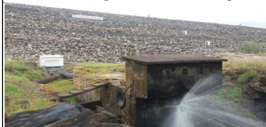
Foto 7 – Vista descarga de fundo São J. Jacuípe
