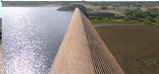
Foto 4 – Vista da barragem Pedras Altas
