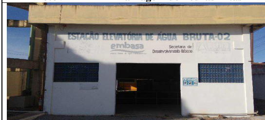
Foto 11 – EEAB II ETA de Capim Grosso
