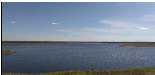
Foto 1 – Barragem de Pedras Altas
