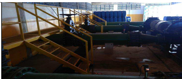
Foto 10 – CMB Barragem Pedra Altas
