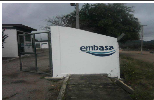
Foto 15 – ETA de SIAA de Pé de Serra
