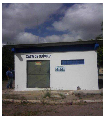
Foto 16 – Casa de Química ETA Pé de Serra
