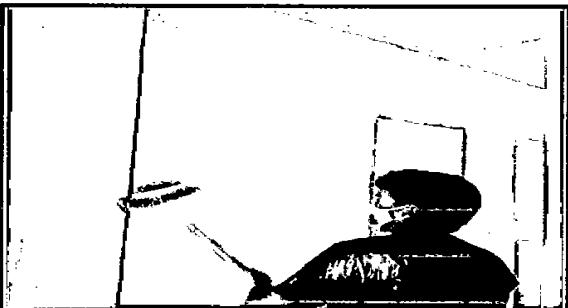
FOTO 11 - EXECUÇÃO DA PINTURA INTERNA. LIXAMENTO, APLICAÇÃO MASSA CORRIDA E APLICAÇÃO DA PINTURA.
