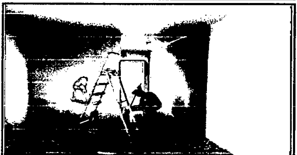
FOTO 12 - EXECUÇÃO DA PINTURA INTERNA. LIXAMENTO, APLICAÇÃO MASSA CORRIDA E APLICAÇÃO DA PINTURA.
