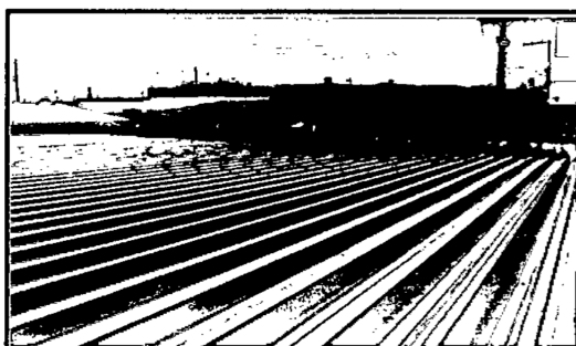
FOTO 48 - EXECUÇÃO DO TELHAMENTO COM TELHA DE AÇO/ALUMÍNIO E = 0,5 MM, COM ATÉ 2 ÁGUAS, INCLUSIVE FIXAMENTO. AF_07/2019
