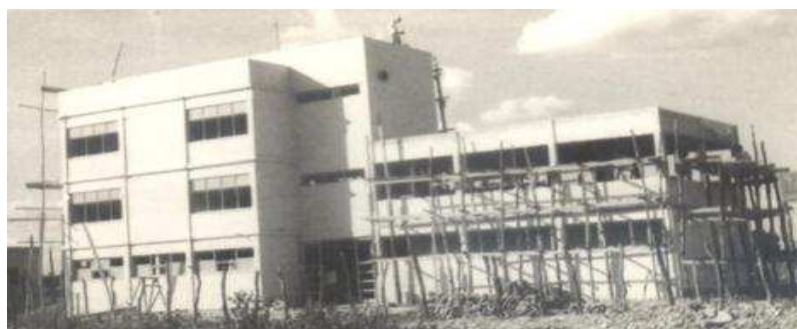
01-CONSTRUÇÃO DA ESTAÇÃO DE TRATAMENTO DE AGUA NA DÉCADA DE 1960
