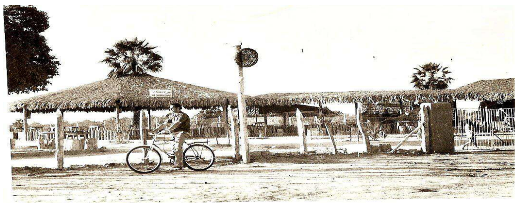
02- CLUBE DE RECREAÇÃO O CARI CONTRUIDO ÀS MARGENS DO RIO, NA PONTA DA ILHA, NA DÉCADA DE 1970
