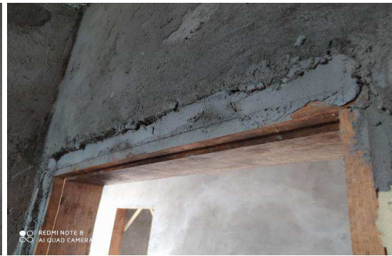
Apontamento 4: Desconformidade do reboco.
