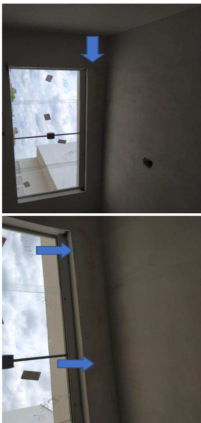
Apontamento 3: Vazamento do telhado.
