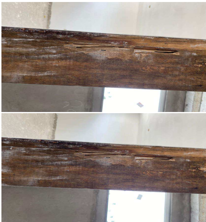
Apontamento 2: Desintegração da madeira da aduela.
