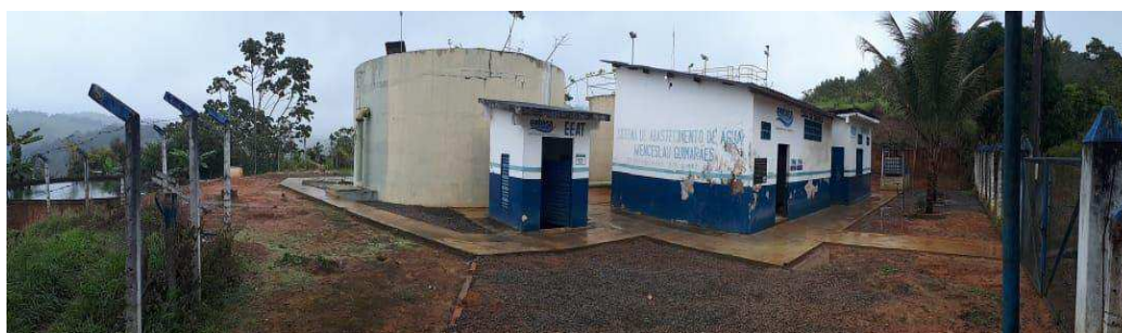
Foto 01 – Estação de Tratamento de Wenceslau Guimarães.
