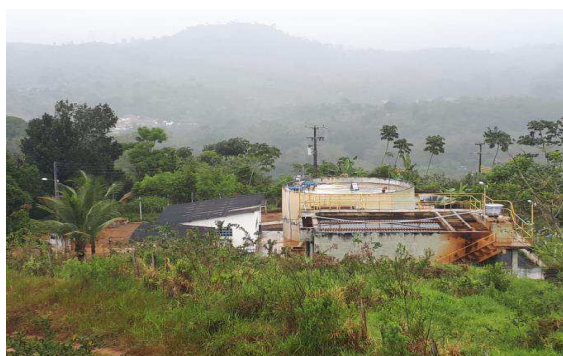
Foto 02 – Unidades Operacionais ETA Wenceslau Guimarães.
